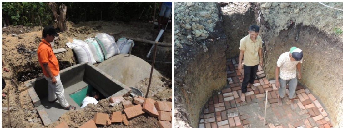
Gambar 1. Proses pembuatan instalasi biogas: pembuatan digester (kiri) dan kolam penampungan sludge dan slurry dari digester (kanan)
