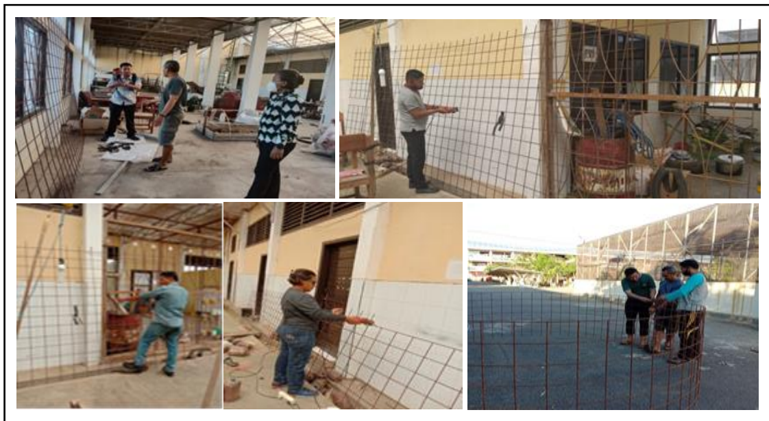
Gambar 6. Persiapan pembuatan rangka di lokasi.
