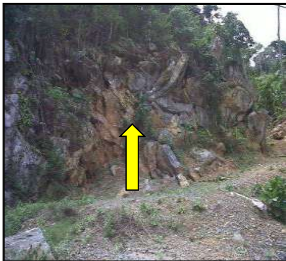
Gambar 6. Runtuhan Batuan “ rockfall ” Lokasi keempat (ST-02).
