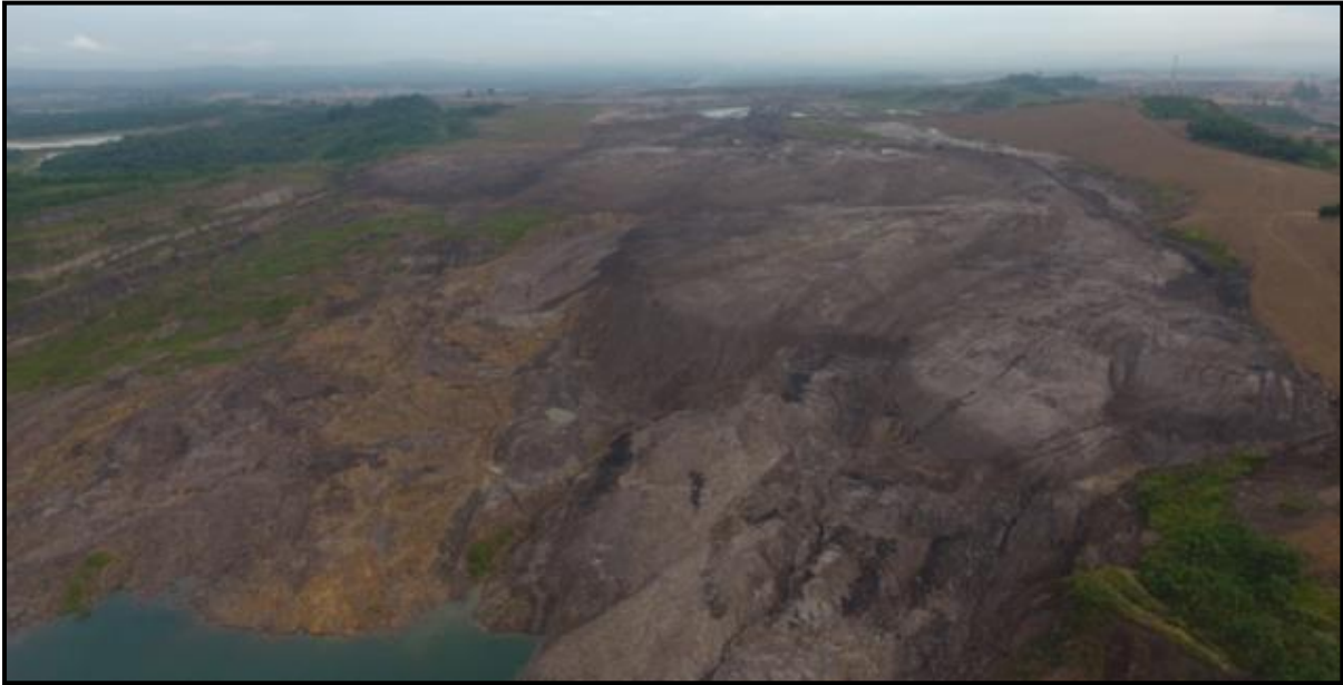
Gambar 1. Kondisi aktual Tiung-AB Dump dengan pembentukan erosi.
